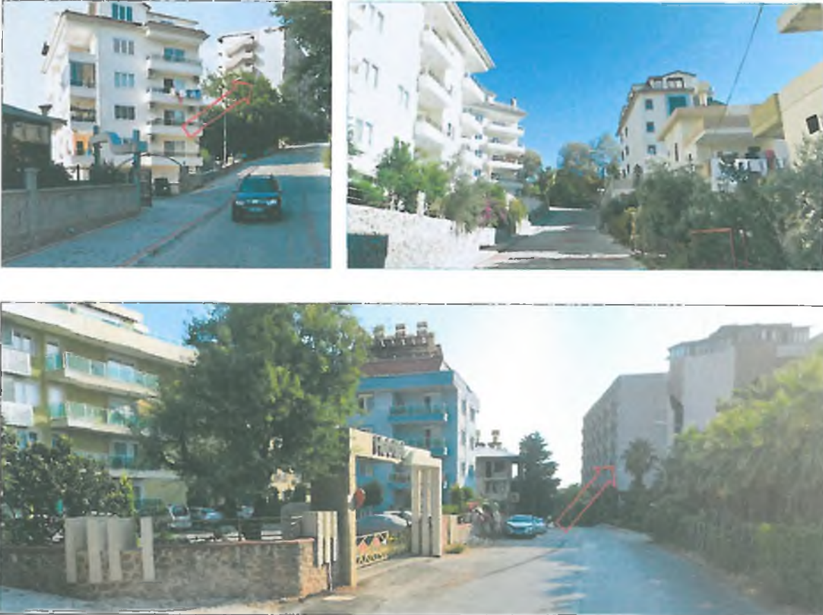
Şekil 4: Plan değişikliğine konu 859 ada 2 numaralı parsel içerisinde yer alan otel yapısı ve yakın çevresindeki konut yapıları
