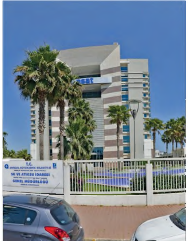
Resim 214: ASAT Genel Müdürlüğü Hizmet Binası
