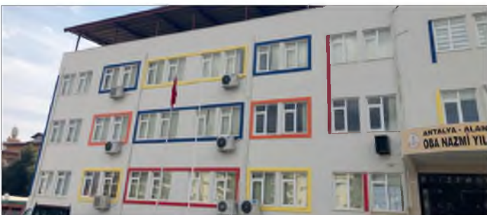
Resim 73: Alanya İlçesi Oba Nazmi Yılmaz Anadolu Lisesi Teras Katında Çatı Yapımı
