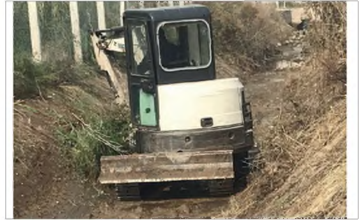
Resim 166: Finike Tekke - Alakır Sulama Tesisi Bakım Onarım ve Kanal Temizliği
