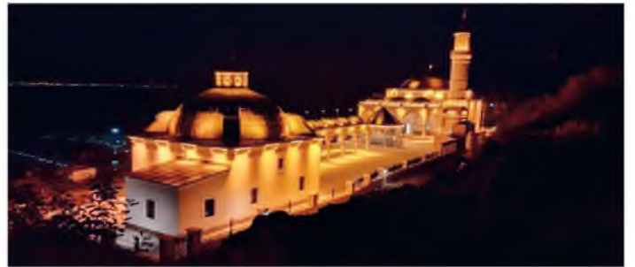
Resim 71: Finike İlçesi Eroğlu Nuri Camii
