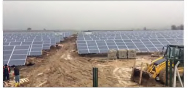
Resim 164: Güneş Enerji Santrali (GES)
