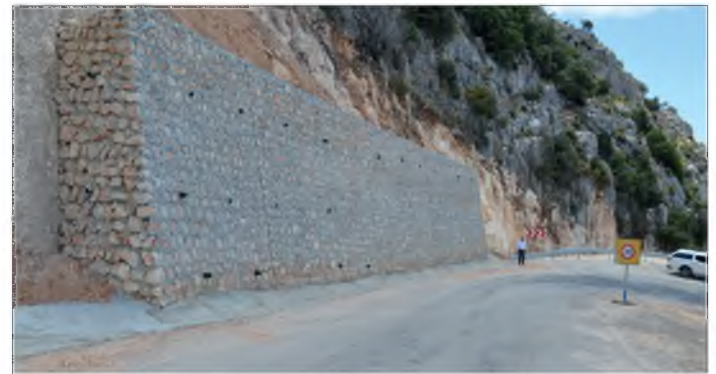
Resim 188: Kaş İlçesi Bezirgan Mahallesi Dayanma Yapısı
