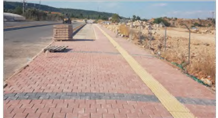
Resim 183: Santral Mahallesi Kaldırım Düzenlemesi
