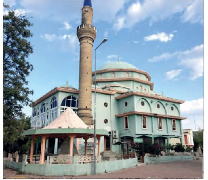
Resim 76: Serik ilçesi Gebiz Mahallesi Merkez Camii
