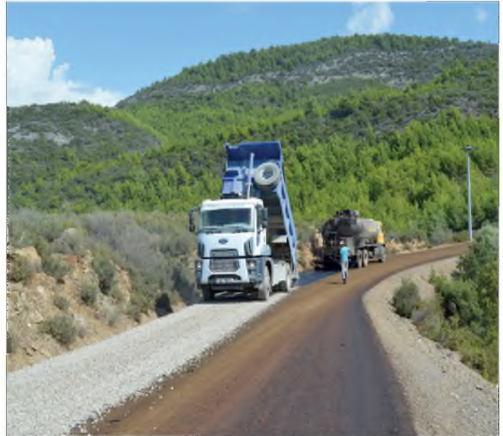
Resim 189: Alanya İlçesi Demirtaş-Büyükpınar-Yeşilöz Sathi Asfalt Çalışması
