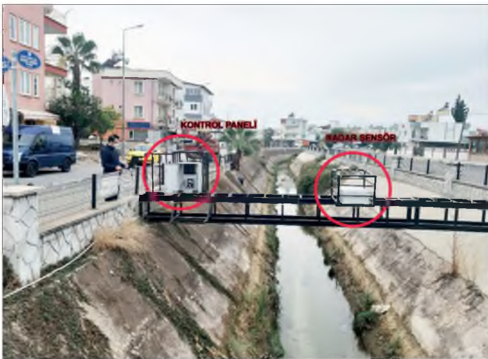
Resim 93: Düden Kanalı Üzeri Anlık Su Seviyesini Ölçen Radar Sensörleri
