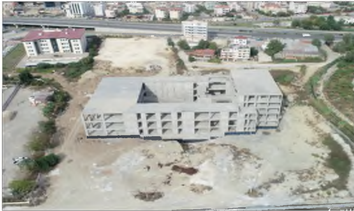
Resim 69: Serik İlçesi Kongre ve Kültür Merkezi İnşaatı
