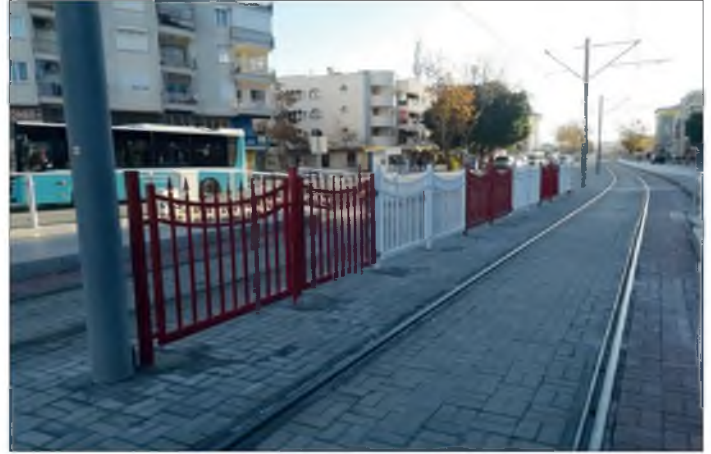
Resim 227: Tramvay Güzergahı Hat Arası Alanda Korkuluk Uygulaması
