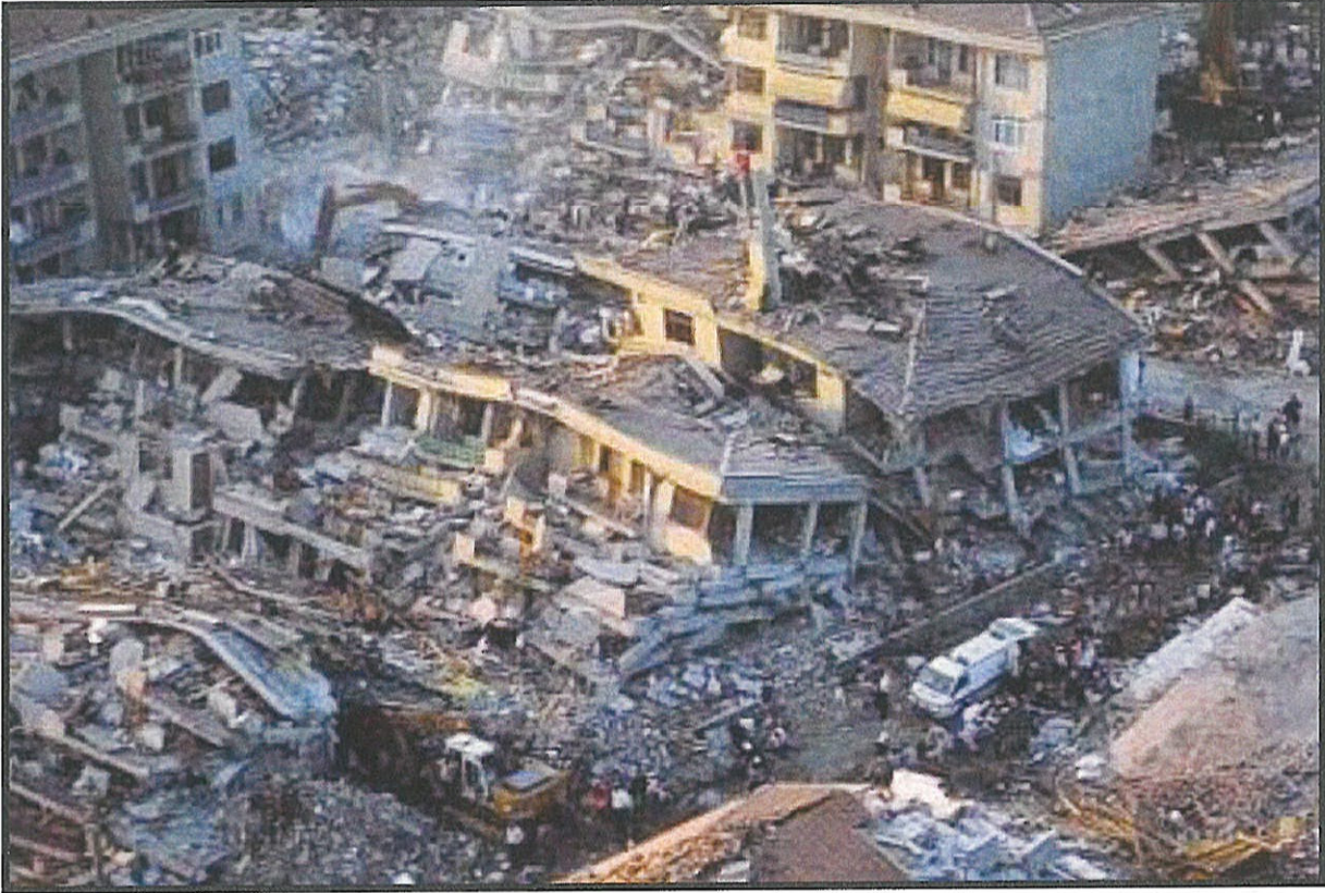
Şekil 8. 17 Ağustos 1999 Marmara Depremi sonucu enkaza dönmüş konut alanı. Resmi raporlara göre, 17.480 ölüm, 23.781 yaralı oldu. 505 kişi sakat kaldı. 285.211 ev, 42.902 iş yeri hasar gördü.
