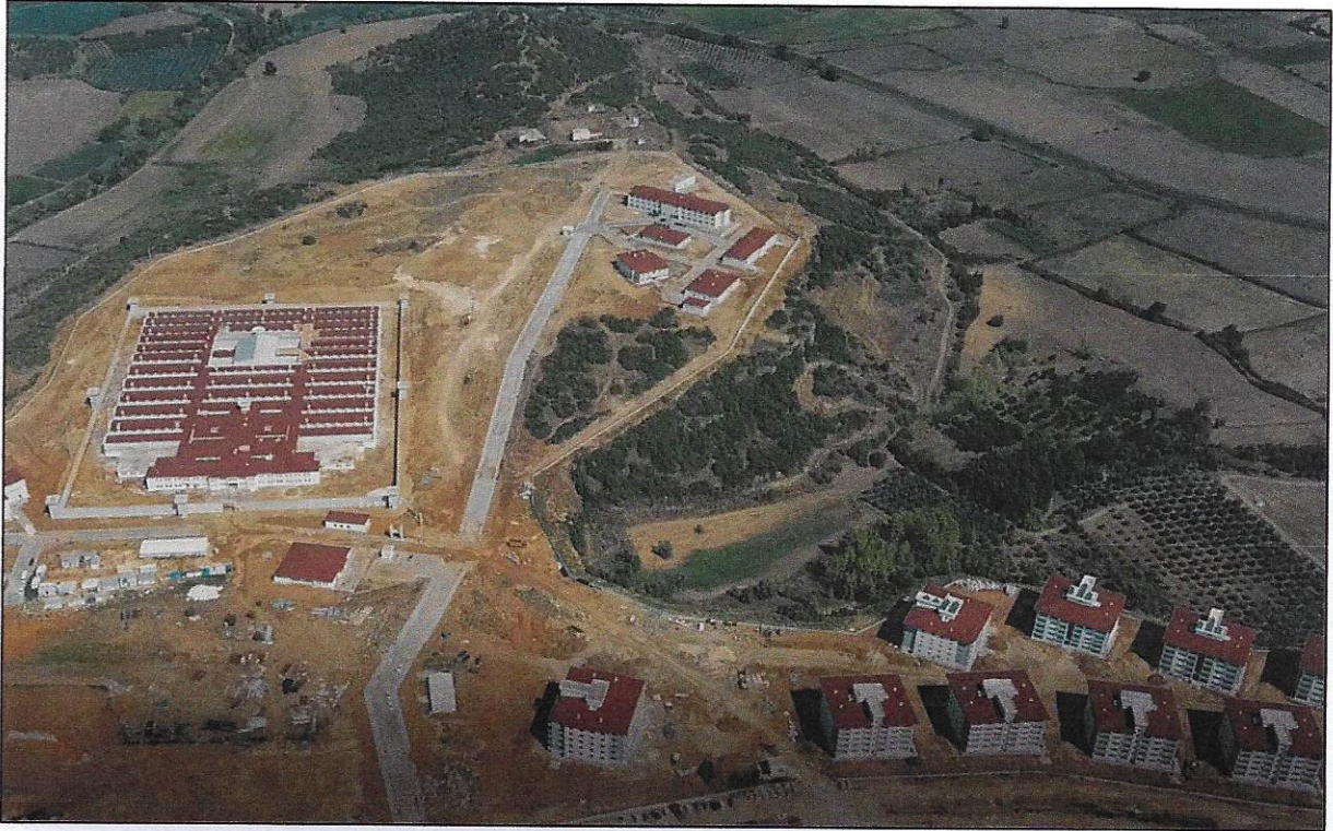
Şekil 5. Manavgat S Tipi Kapalı ve Açık Ceza İnfaz Kurumu Genel Görünüm
