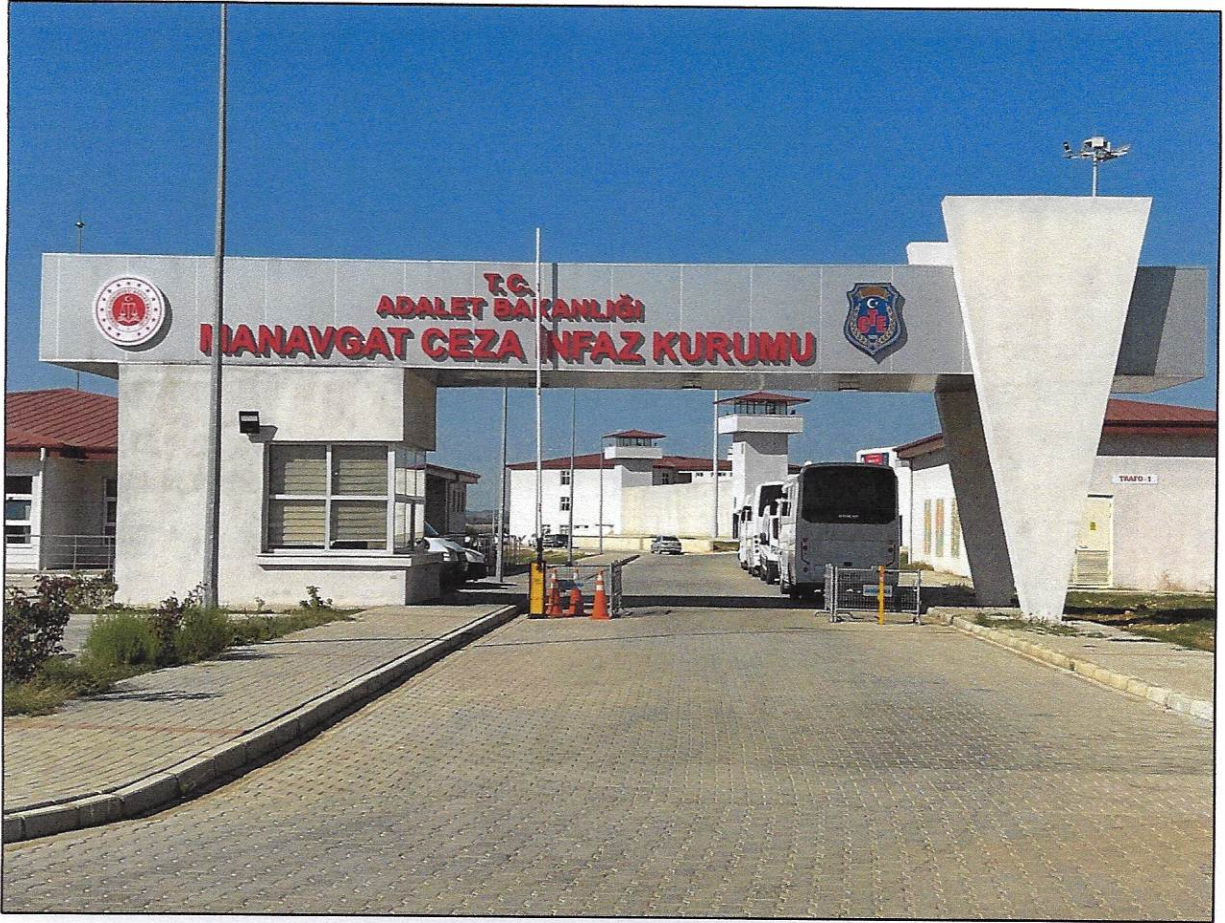
Şekil 4. Manavgat S Tipi Kapalı ve Açık Ceza İnfaz Kurumu Girişi
