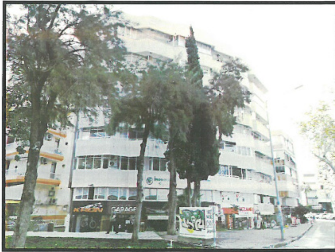
Suzan Apt (1 nolu) ve Ekin Apt (33 Nolu) Yapı Durumu
