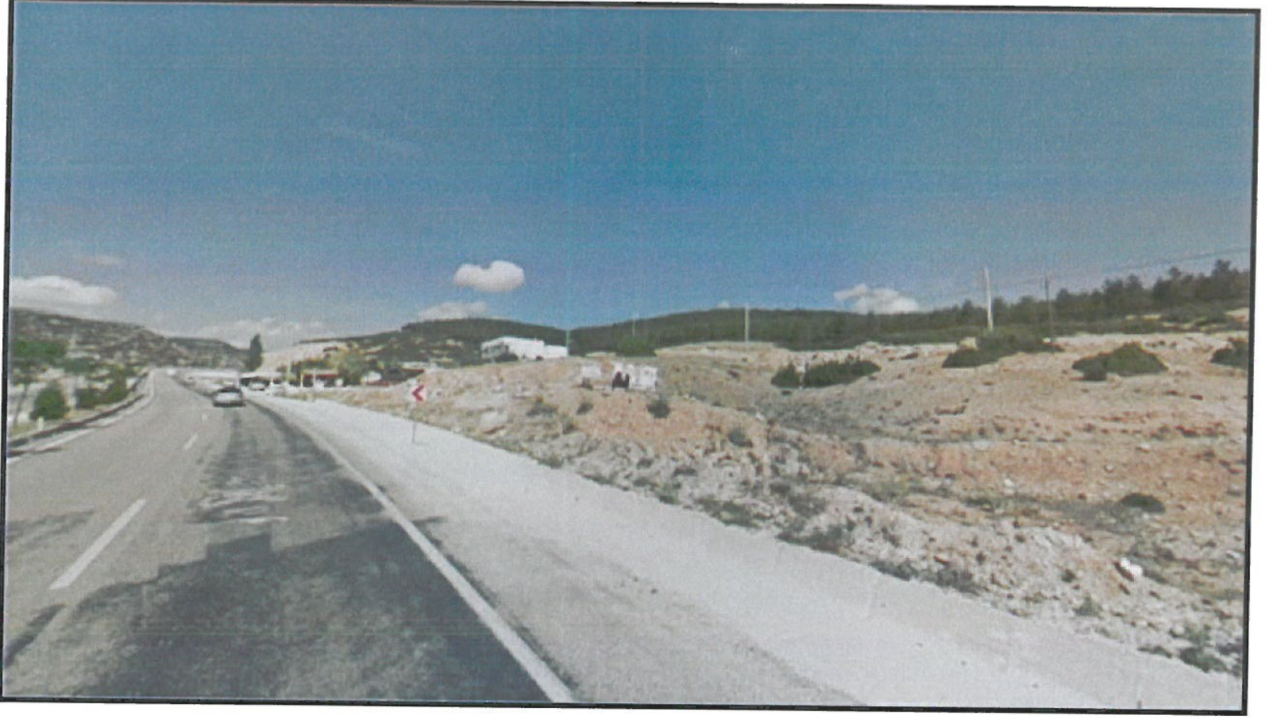
Şekil 8. 194 ada 4-5-6-7-8 parselin bulunduğu alandan görünümü
