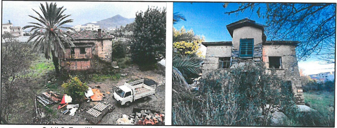
Şekil 8. Tescilli yapının kuzey cepheden görünümü(soldaki) ve güney cepheden görünümü(sağdaki)
