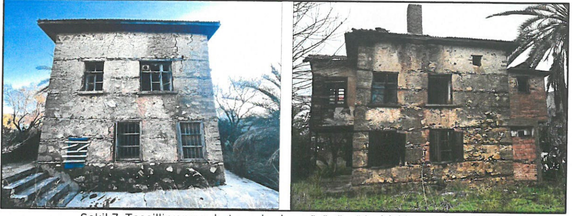
Şekil 7. Tescilli yapının batı cepheden görünümü(soldaki) ve doğu cepheden görünümü(sağdaki)
