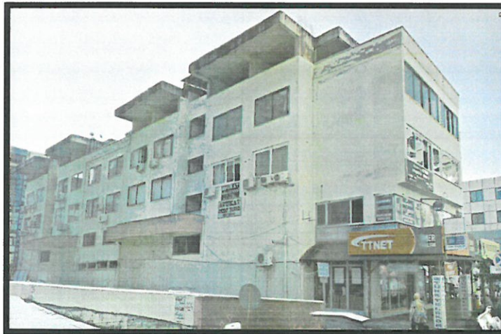
46 Ada 60 ve 10 Parseller Mevcut Durumu (İş Merkezi)
