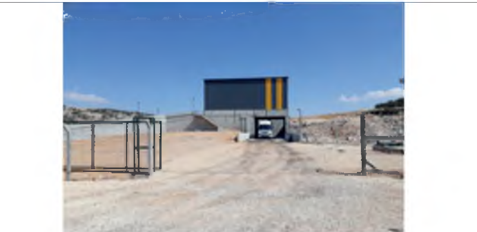
Resim: Elmalı İlçesi Transfer İstasyonu
