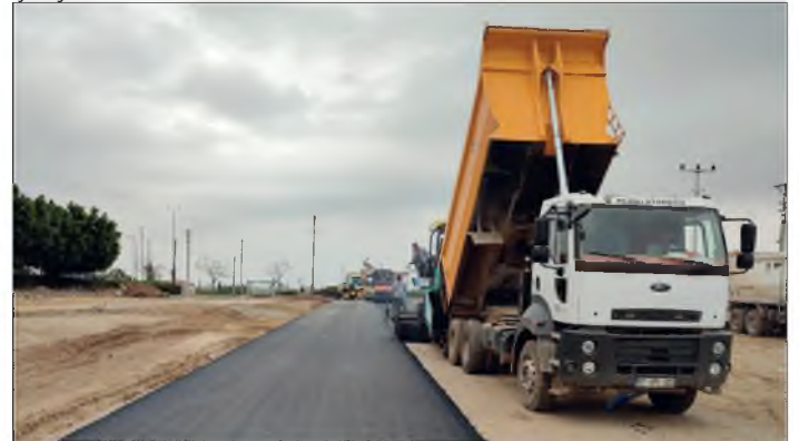
Resim: Çalkaya Bölgesi Kentsel Dönüşüm ve Gelişim Alanı
