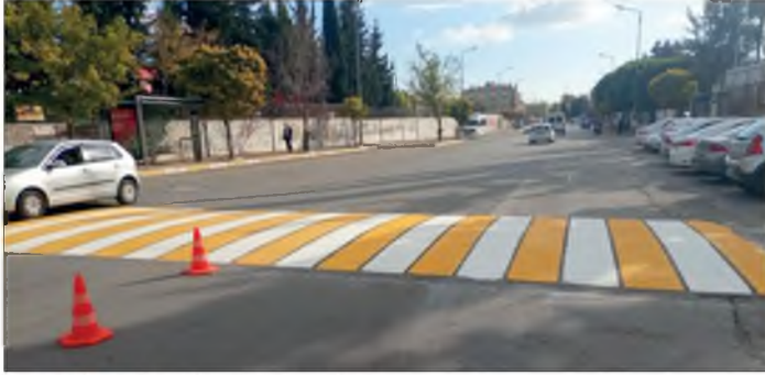
Resim: Yatay İşaretleme Çalışmaları 1
