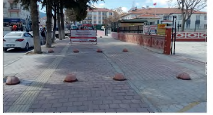
Resim: Korkuteli İlçesi Kaldırım Çalışması
