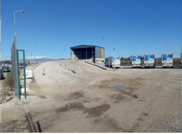
Resim: Serik İlçesi Katı Atık Transfer İstasyonu
