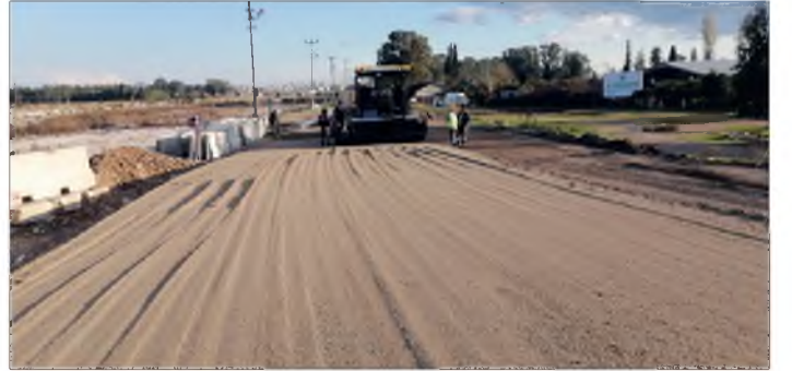
Resim: Karaman Köprüsü Yol Çalışması
