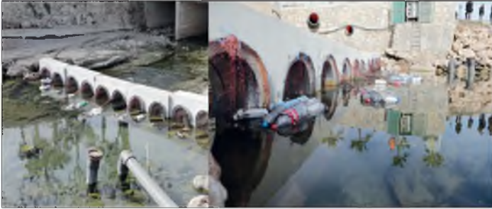
Resim: Konyaaltı İlçesi Arapsuyu Yüzey Suyu Atık Kapanı
