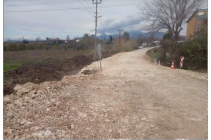
Resim: Serik İlçesi Burmahancı Mahallesi Altyapı Çalışması
