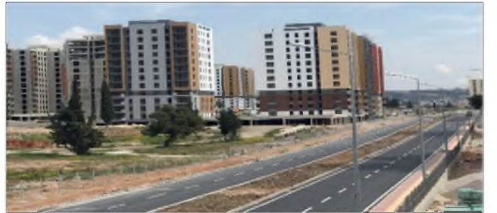
Resim: 3283 Sokak Yol Çalışması
