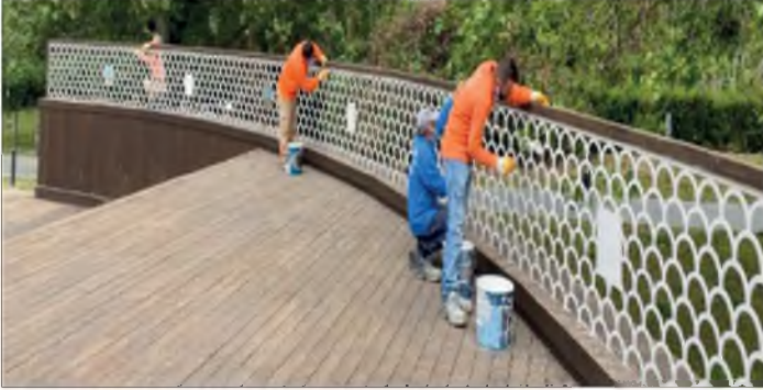
Resim: Tamir ve Bakımı Yapılan Demir Donatılar
