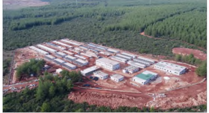
Resim: Sokak Hayvanları Bakım Evi Yapımı
