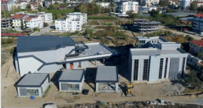
Resim: Gazipaşa İlçesi Kültür Merkezi ve Çok Amaçlı Bina Yapımı
