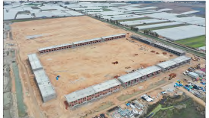
Resim: Kaş İlçesi Kınık Mahallesine Toptancı Hal Yapımı
