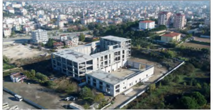
Resim: Serik İlçesi Kültür Merkezi İnşaatı
