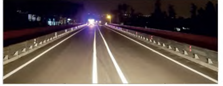
Resim: Karaman Köprüsü Yol Çizgi Çalışması
