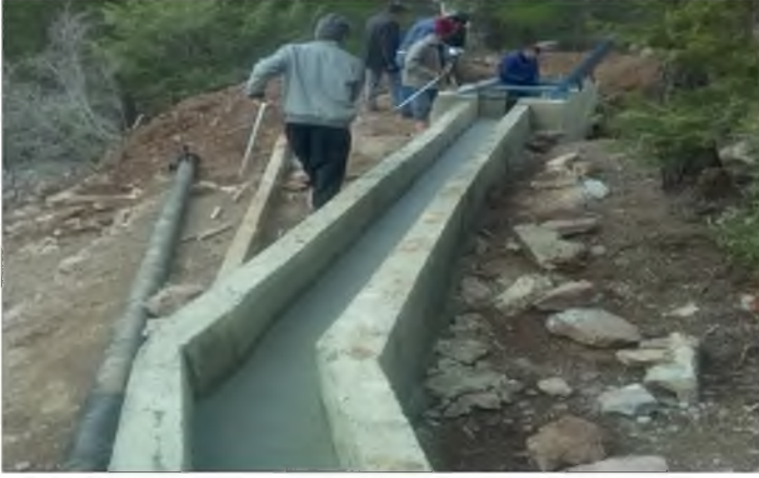
Resim: Gündoğmuş İlçesi Köprülü Mahallesi Sulama Tesisi
