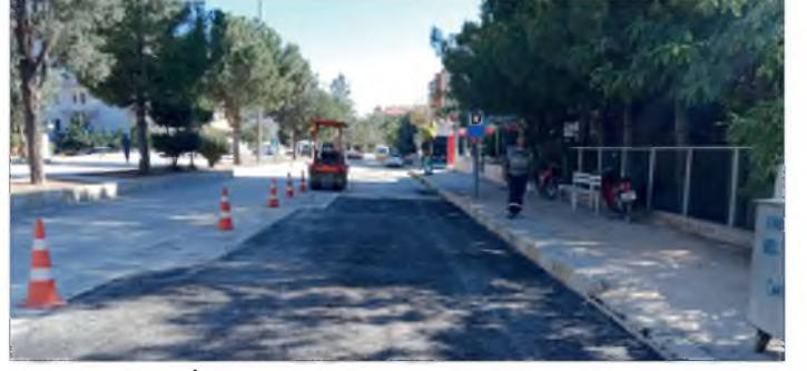
Resim: Korkuteli İlçesi Asfalt Yama Çalışması
