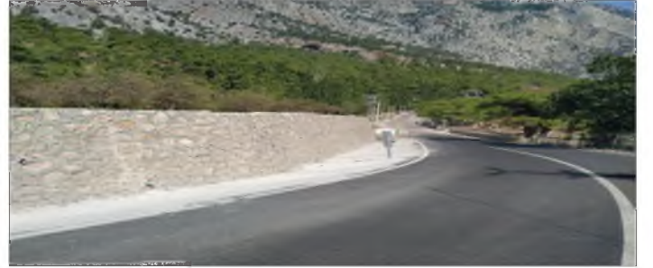
Resim: Konyaaltı İlçesi Hacisekililer – Yarbaşıçandır Mahallesi Arası İstinad Duvarı Çalışması
