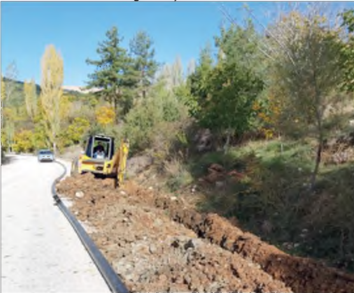
Resim: Kaş İlçesi Yuvacık Mahallesi Sulama Tesisi
