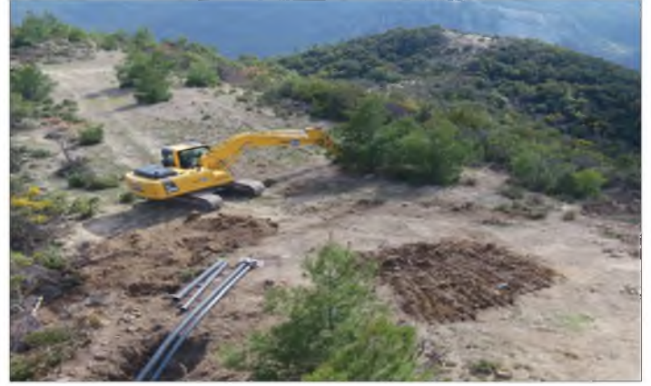
Resim: Manavgat İlçesi Çardak Taşağıl Mahallesi Sulama Tesisi
