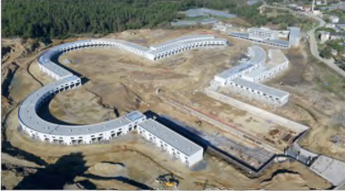
Resim: Alanya İlçesi Toptancı Hali Yapımı
