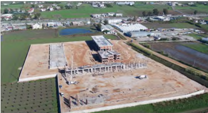
Resim: Manavgat İlçesi Toptancı Hal Kompleksi Yapımı
