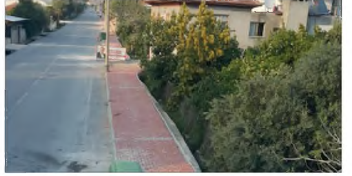
Resim: Finike İlçesi Atatürk Caddesi Kaldırım Çalışması
