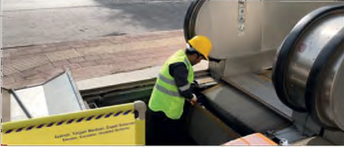
Resim: Üst Geçitlerdeki Asansör ve Yürüyen Merdivenlerin Bakım ve Onarımı
