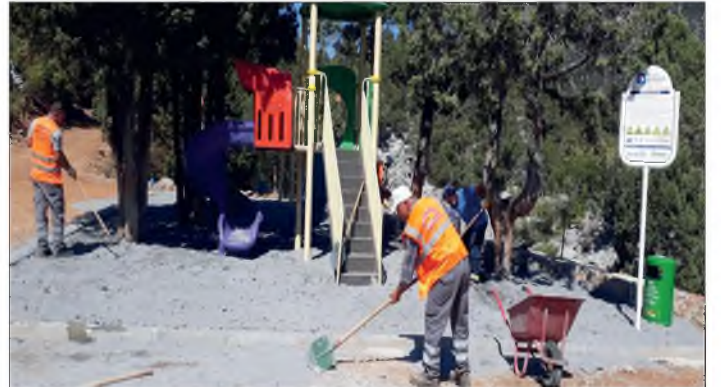
Resim: Akseki İlçesi Susuzşahap Mahallesi Park Yapımı
