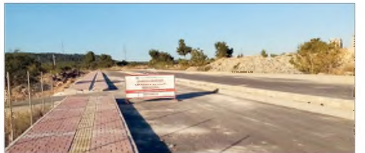
Resim: 3284 Sokak Kaldırım Çalışması
