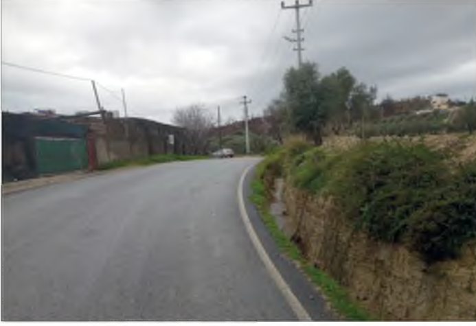
Resim: Manavgat İlçesi Aksaz Mahallesi Asfalt Çalışması
