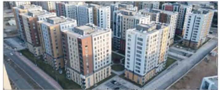
Resim: Proje Alanında İnşaat Faaliyetleri
