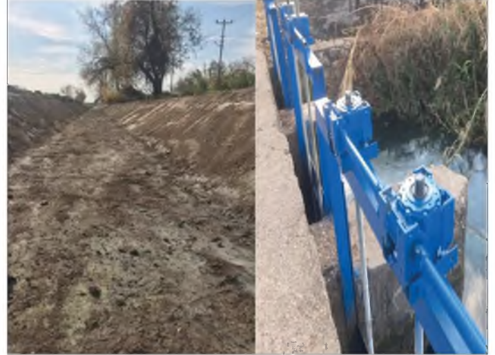
Resim: Finike Tekke Alakır Sulama Tesisi Bakım Onarım ve Kanal Temizliği
