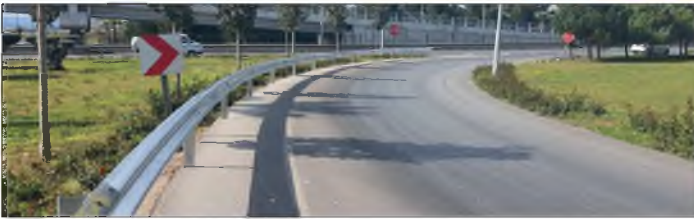
Resim: Büyükşehir Belediyesi Sorumluluk Ağındaki Yerlere Oto Korkuluk Yapımı
