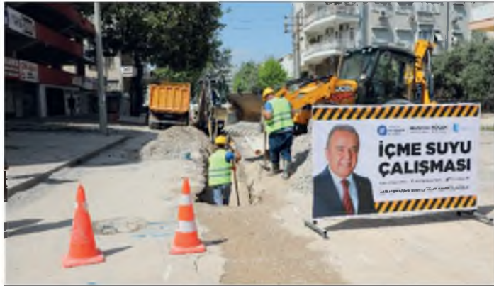
Resim: İçme Suyu Altyapı Çalışması
