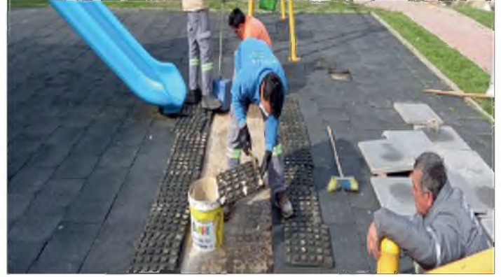
Resim: İnşaat Atölyesi Çalışmaları
