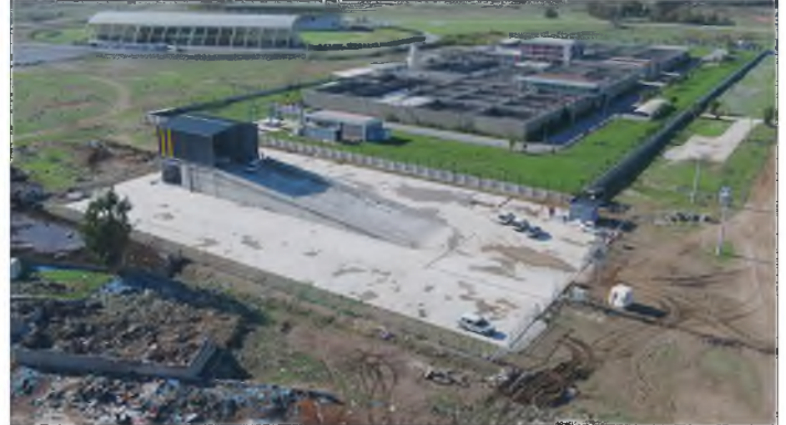
Resim: Manavgat İlçesi Katı Atık Aktarım Tesisi Yapımı
