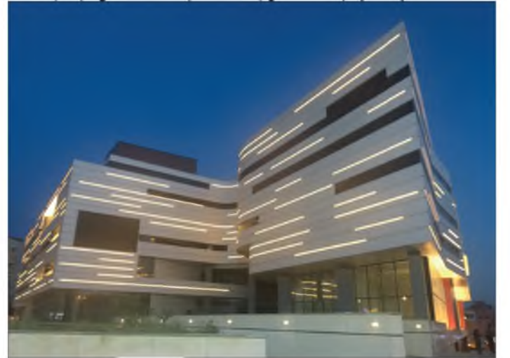
Resim: Doğu Garajı Kültür ve Ticaret Merkezi Yapımı
