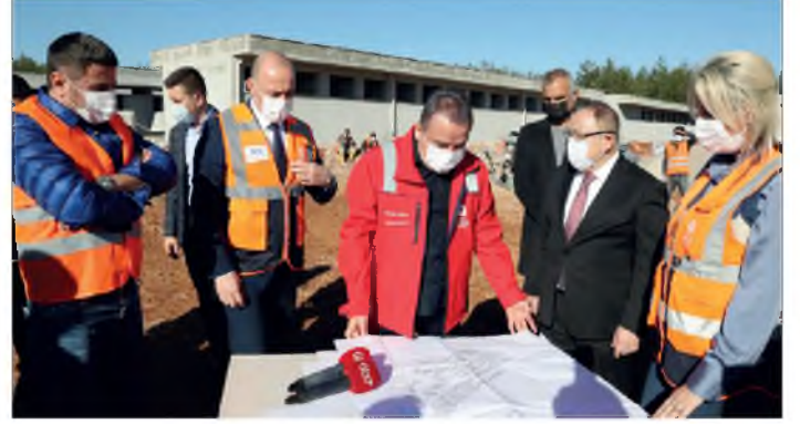
Resim: Yeni Sahipsiz Hayvan Bakımevi Yapım Aşaması
