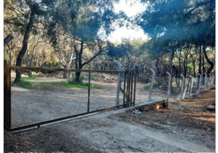
Resim: İhata Duvarı
