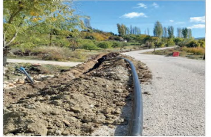
Resim: Kaş İlçesi Yuvacık Mahallesi Sulama Tesisi
