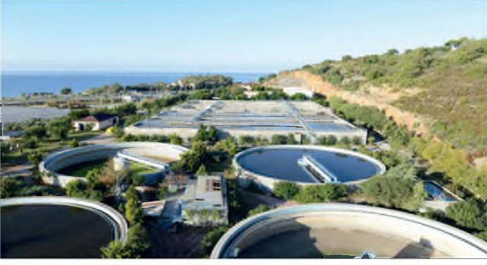
Resim: Atıksu Arıtma Tesisi
