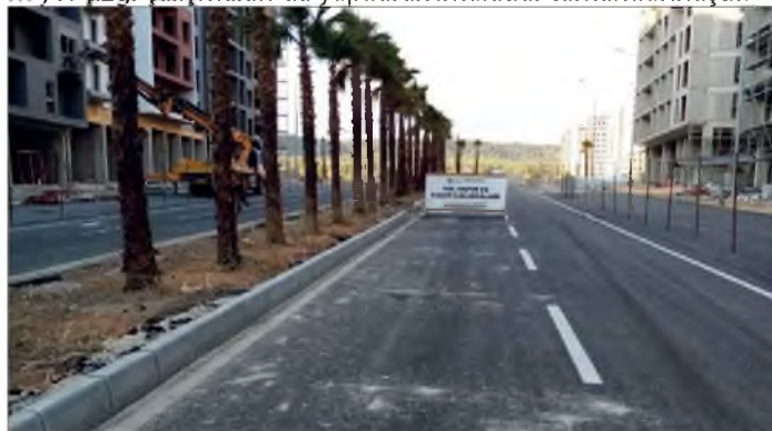
Resim: 3281 Sokak Yol Çalışması
