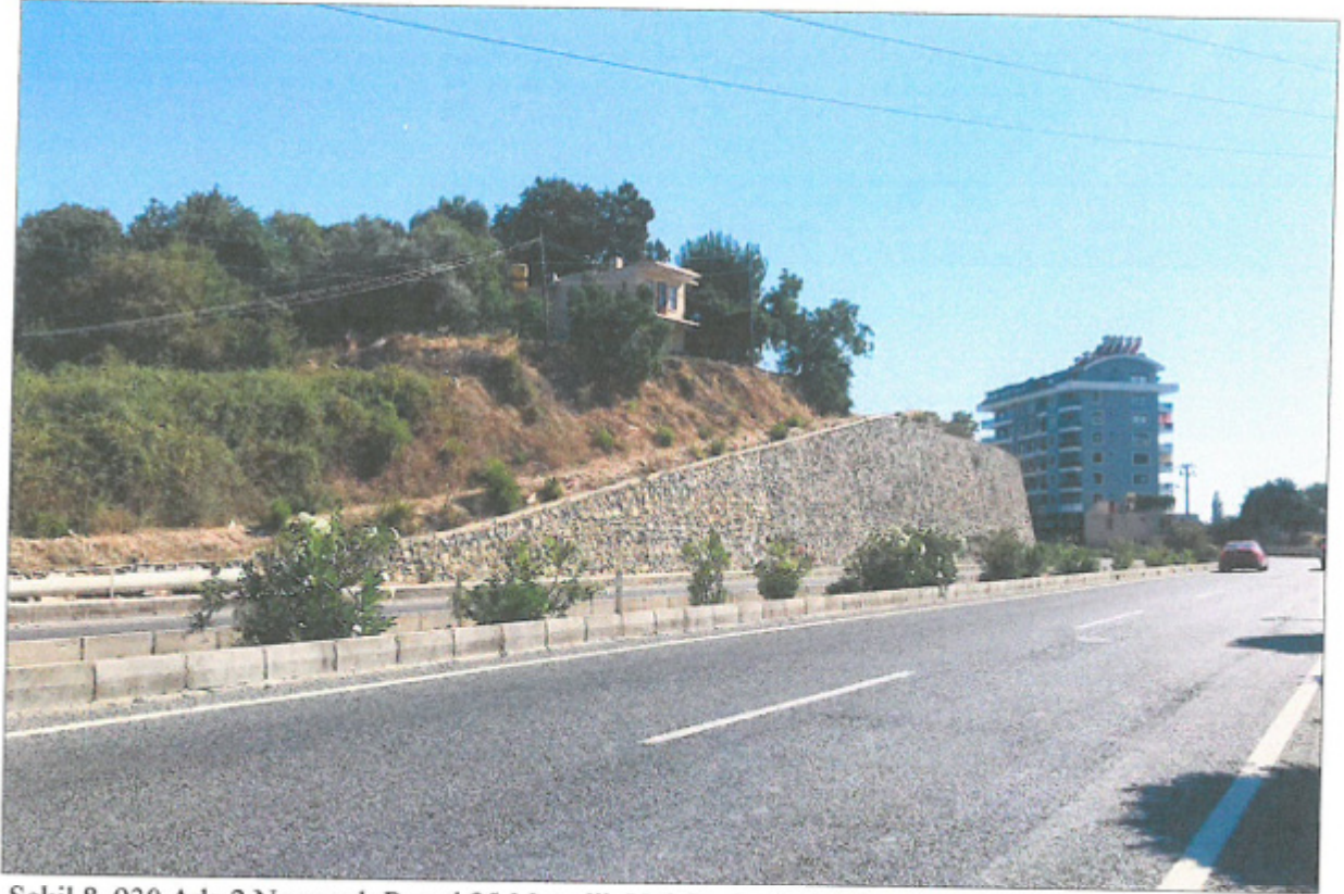
Şekil 8. 930 Ada 2 Numaralı Parsel 25 Metrelik Yol Cephesinde Yer Alan 12 Metre Yüksekliğindeki İstinat Duvarı ve İçerisindeki Yapı
