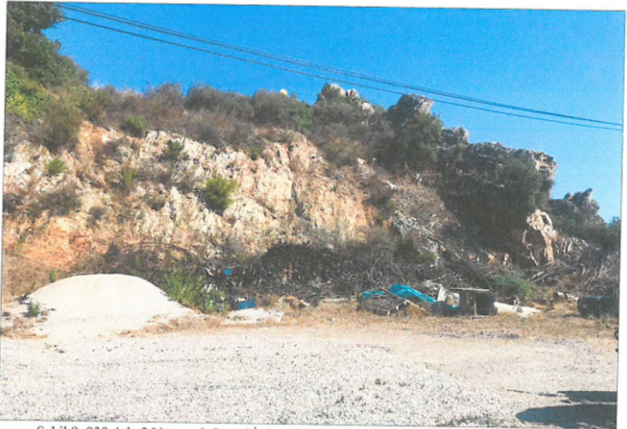
Şekil 9. 930 Ada 2 Numaralı Parsel İstinat Duvarı üstünden arazinin doğusunun görünüşü
