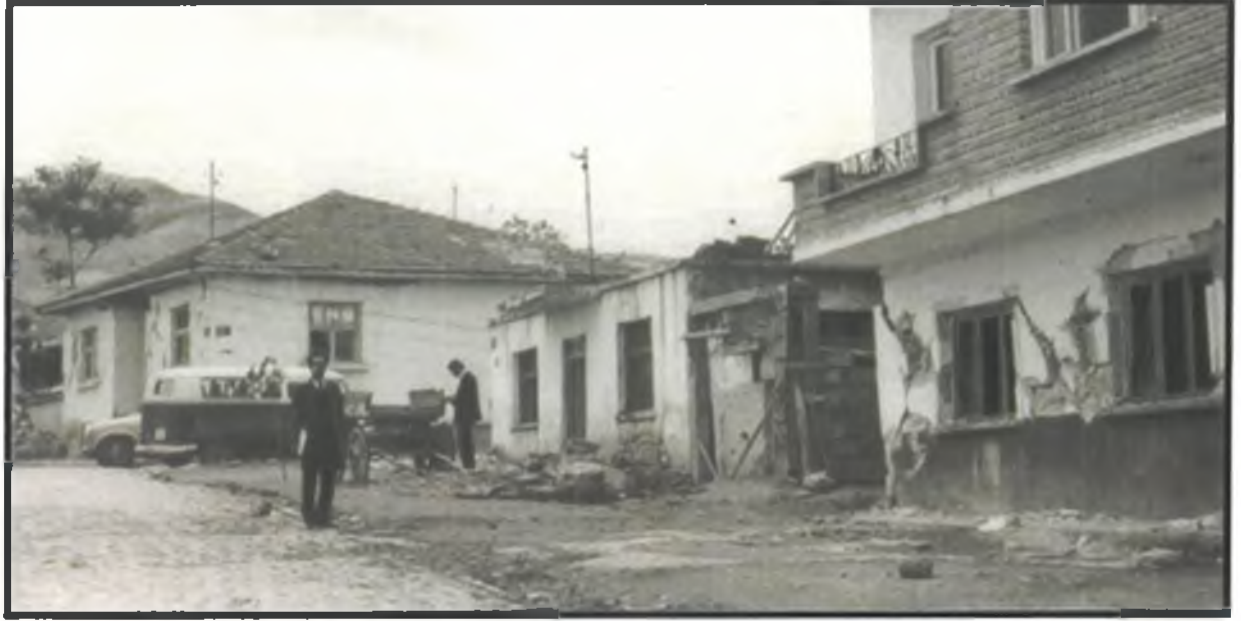
Şekil 6. 12 Mayıs 1971 Burdur depreminden sonra Burdur'da bir sokak. Burdur ve çevresinde gece meydana gelen 6,2 şiddetli depremde 57 kişi öldü, 1.162 cv yıkıldı.
