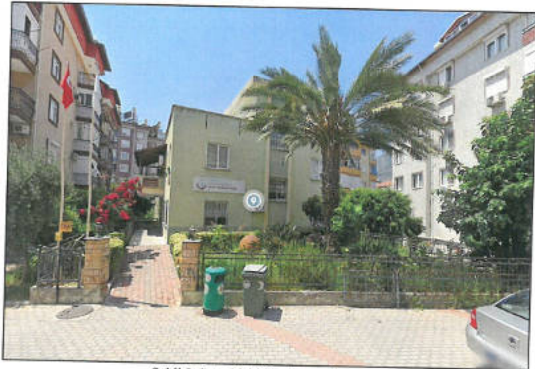
Şekil 3. Parseldeki Yapılaşma Durumu
