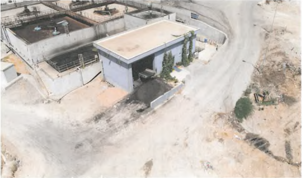
Şekil 3.14 Alanya Entegre Katı Atık Tesisi arıtma sistemi genel görünümü, 2022
