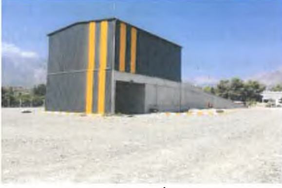
Kemer Aktarma İstasyonu
