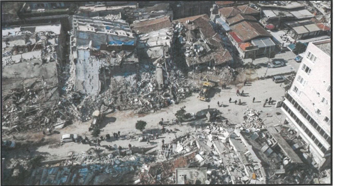
Şekil 11. 6 Şubat 2023 Kahramanmaraş Depremi Sonucu Enkaza Dönmüş Konut Alanı.
