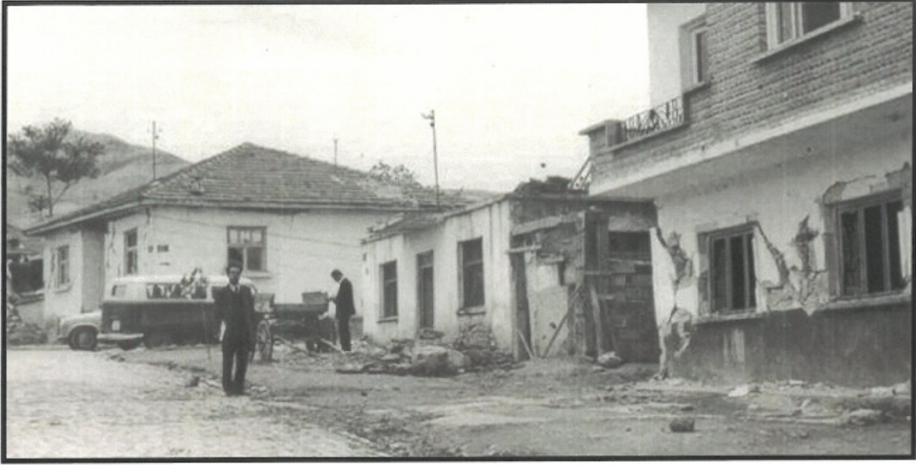
Şekil 6. 12 Mayıs 1971 Burdur depreminden sonra Burdur'da bir sokak. Burdur ve çevresinde gece meydana gelen 6,2 şiddetli depremde 57 kişi öldü, 1.162 ev yıkıldı.
