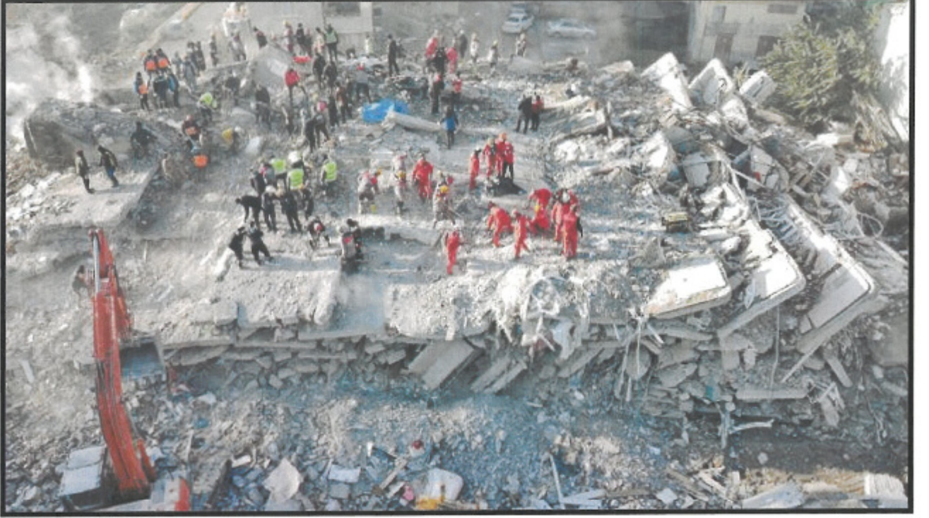
Şekil 10. 6 Şubat 2023 Kahramanmaraş Depremi Sonucu Enkaza Dönmüş Konut Alanı.
