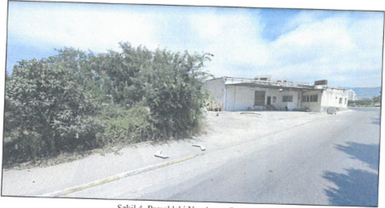
Şekil 4. Parseldeki Yapılaşma Durumu
