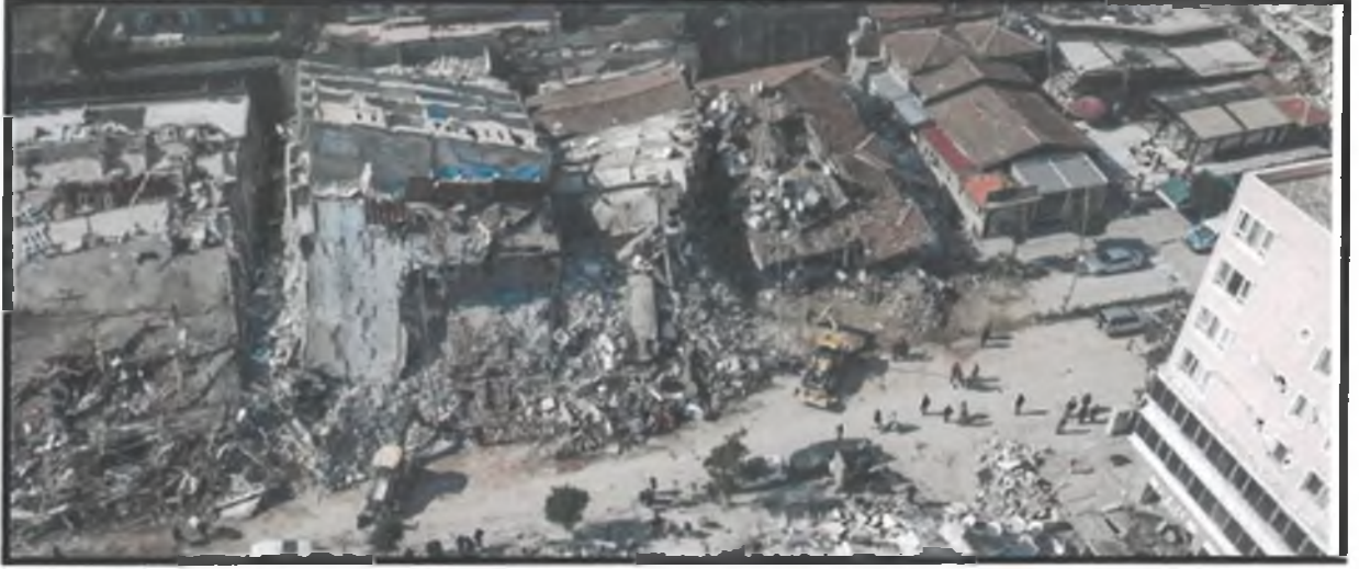
Şekil 8 6 Şubat 2023 Kahramanmaraş Depremi Sonucu Enkaza Dönmüş Konut Alanı.
