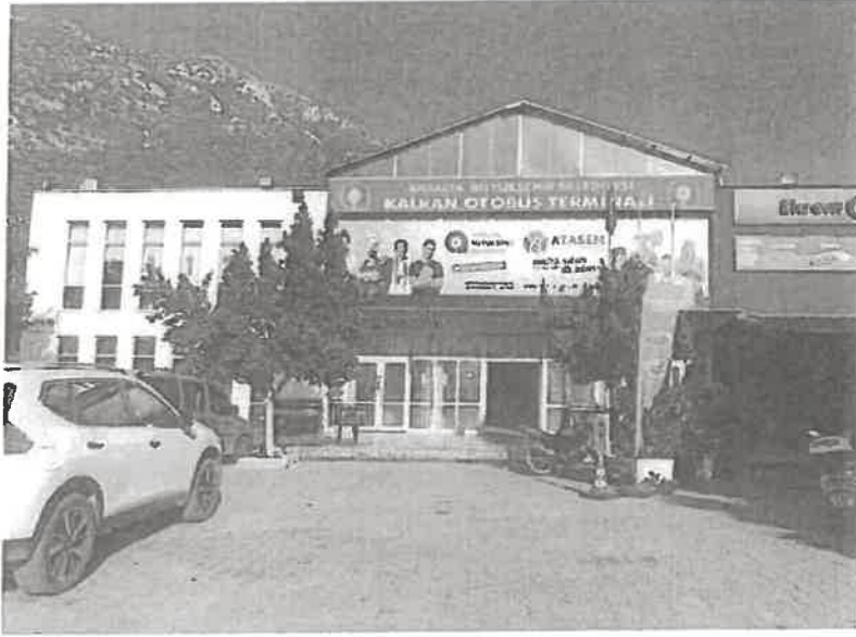
Resim 1 : Otogar/Hizmet Alanı Binası
