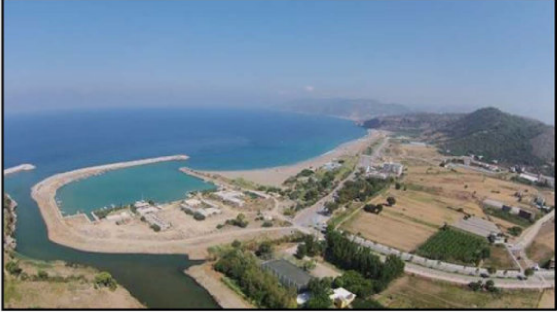
Şekil 15. Pazarıcı Mahallesi Görünümü
