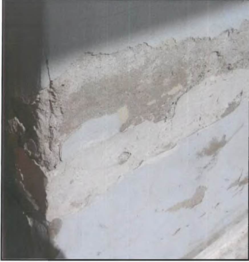
RESİM.2. 5823 ADA 1 PARSEL İÇERİSİNDE YER ALAN YAPILARIN DURUMU
