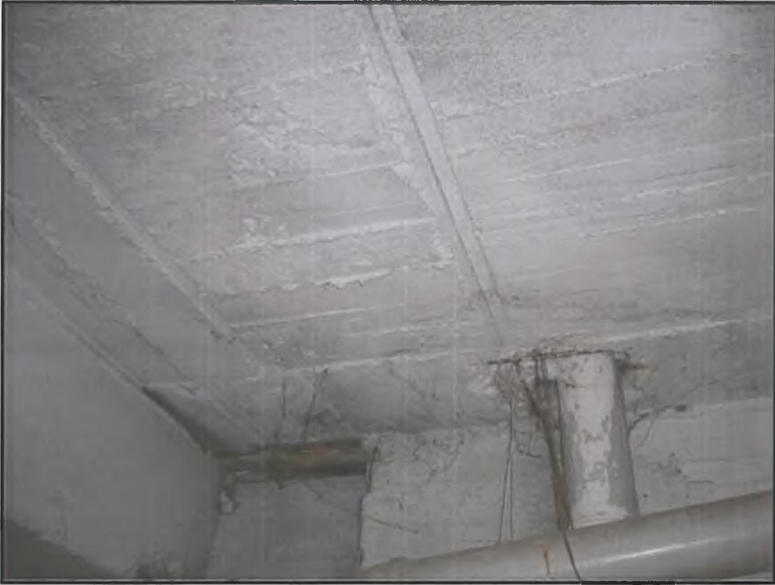
RESİM.1. 5823 ADA 1 PARSEL İÇERİSİNDE YER ALAN YAPILARIN DURUMU
