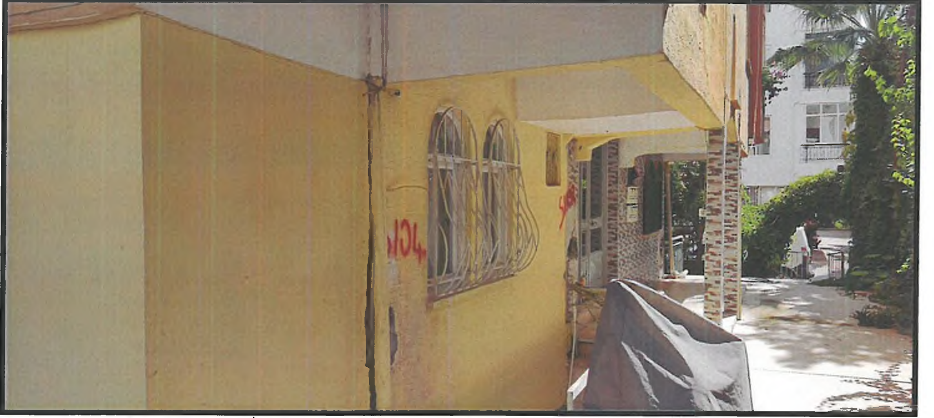
Resim 1. 3958 Ada, 17 Parsel İçerisindeki binanın görseli.
