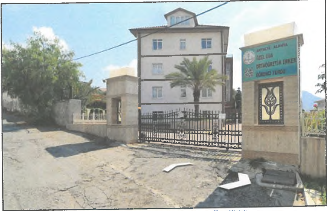
Şekil 5: Parselin Batı Cepheden Görünümü (Yurt Girişi)
