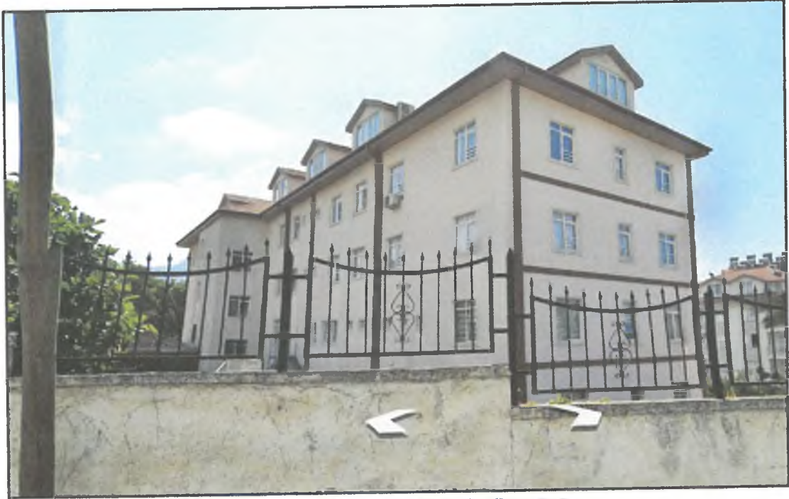
Şekil 6: Parselin Arka Yan Cepheden Görünümü
