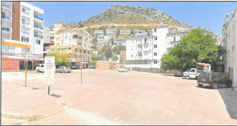
Şekil 2. Parsel içerisinde mevcut yapının yol cephesinden görünüşü
