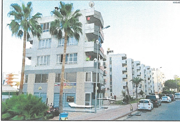
Şekil 9. Taşınmazlarda yer alan yapıların kuzey yönünden görünümü (Yıkım öncesi)
