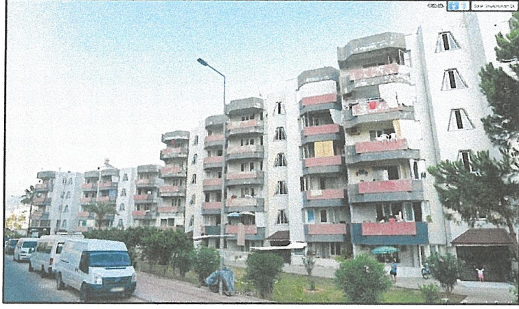
Şekil 8. Taşınmazlarda yer alan yapıların batı yönünden görünümü (Yıkım öncesi)
