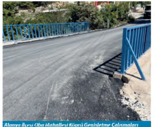
Alanya İlçesi Oba Mahallesi Köprü Geniştirme Çalışmaları
