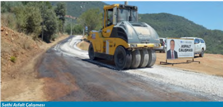
Sathi Asfalt Çalışması
