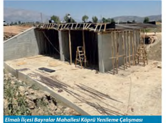
Elmalı İlçesi Bayralar Mahallesi Köprü Yenileme Çalışması
