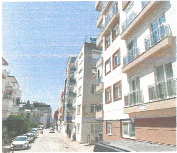
Resim 3 : parseldeki binanın durumu
