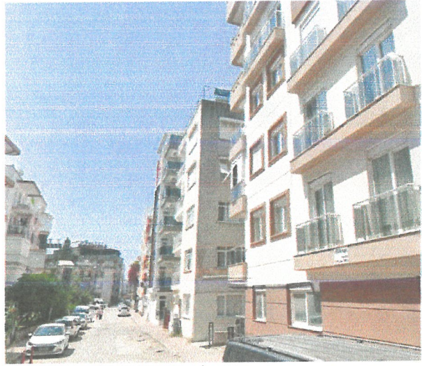
Resim 3 : parseldeki binanın durumu
