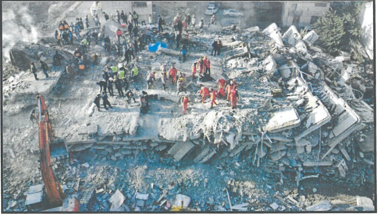
Şekil 9. 6 Şubat 2023 Kahramanmaraş Depremi Sonucu Enkaza Dönmüş Binalar.
