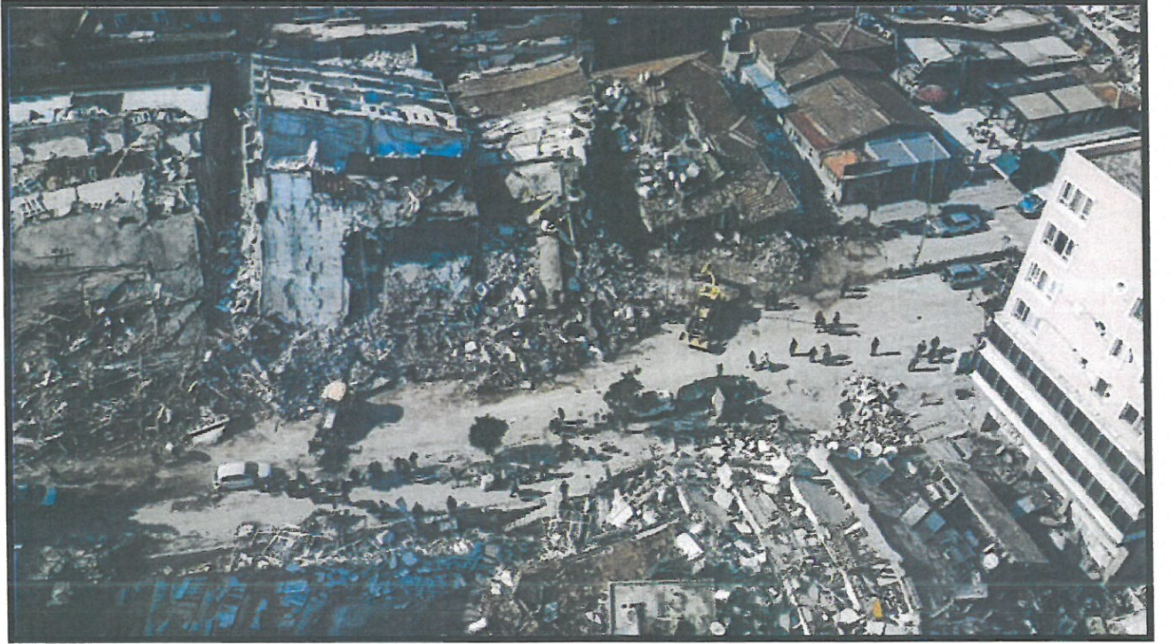
Şekil 10. 6 Şubat 2023 Kahramanmaraş Depremi Sonucu Enkaza Dönmüş Binalar.
