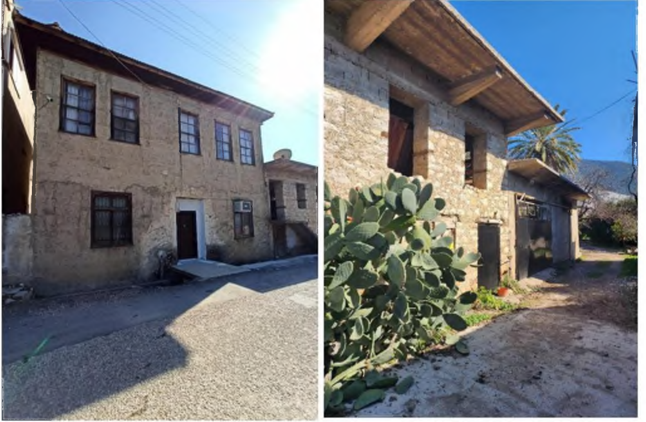
Şekil 28 13-A Envanter Numaralı Tescilli Yapı Batı Görünümü ve Eklentilerinin Güney Görünümü
