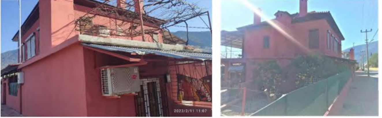
Şekil 33 17 numaralı tescilli yapının güneybatı ve kuzeybatı görünümü
