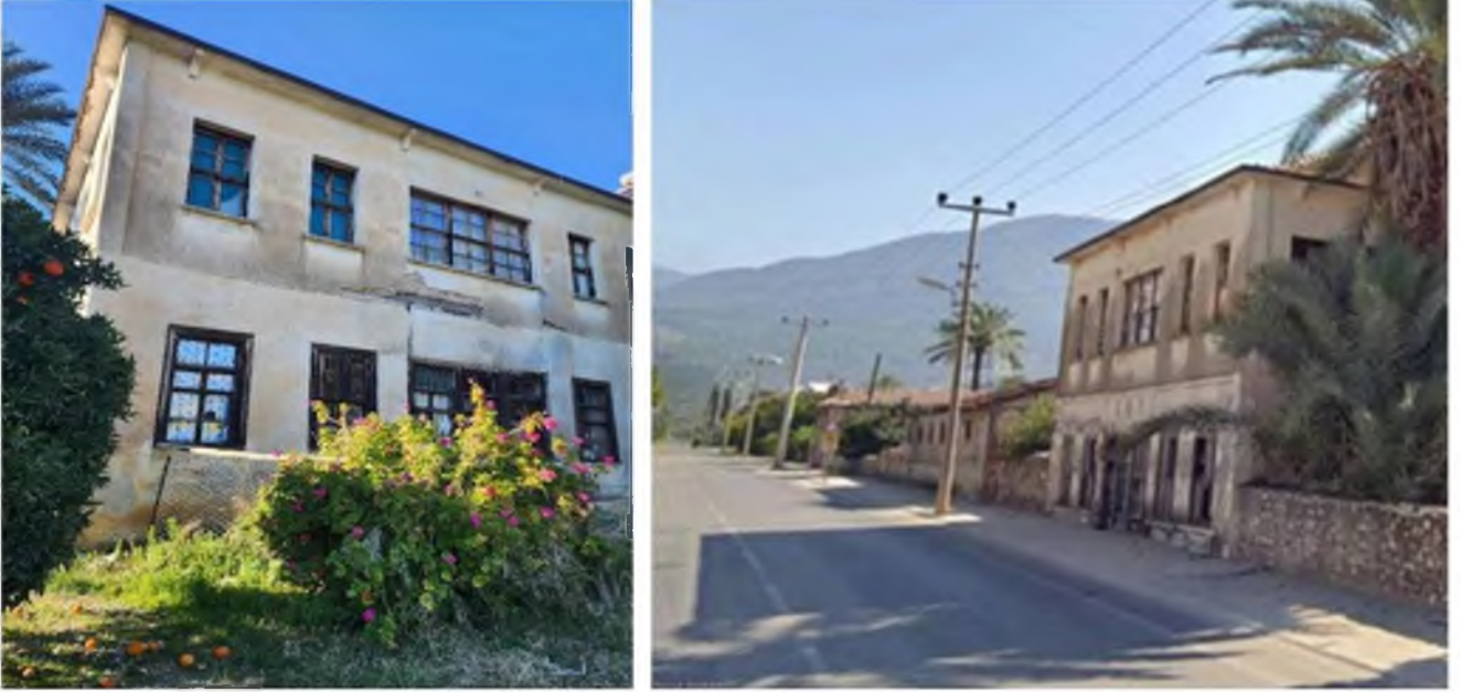
Şekil 13 1 Envanter Numaralı Tescilli Ana Yapı Batı ve Doğu Cephe Fotoğrafları
