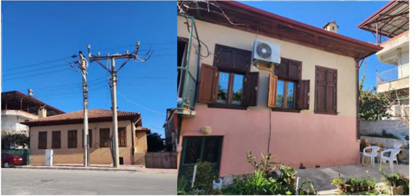
Şekil 20 6 Envanter Numaralı Tescilli Yapı Batı ve Doğu Cephe Görünümleri
