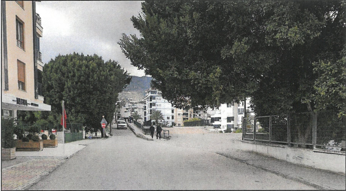
Şekil 11. Alternatif köprü ile 12 metrelik taşıt yolunun birleştiği yerdeki durumu
