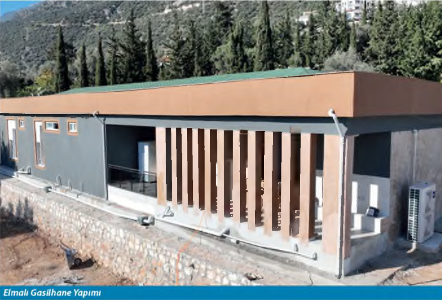
Elmalı Gasilhane Yapımı
