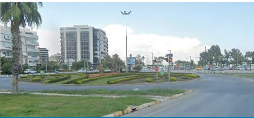
Akdeniz Bulvarı Kavşak Çalışması
