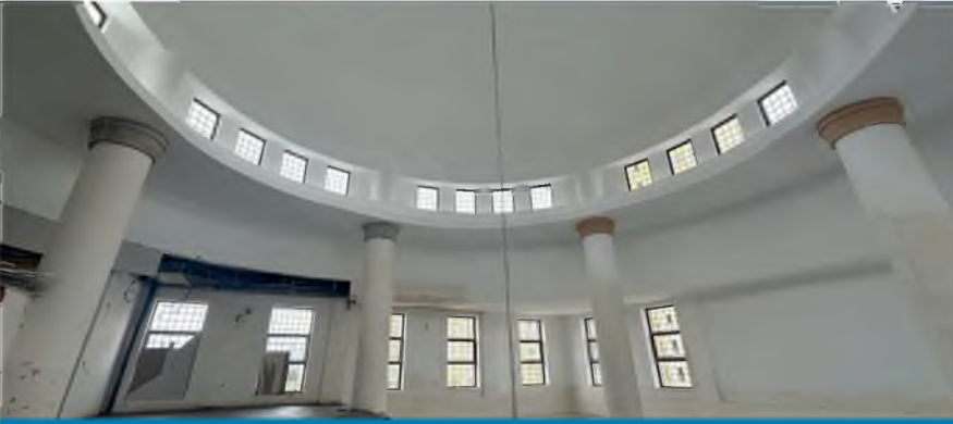
Kepez Güneş Mahallesi Camii Yapımı
