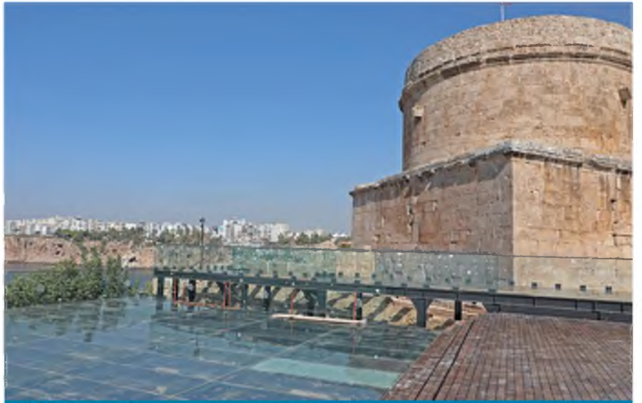
Hidrelük Çevre Düzenlemesi
