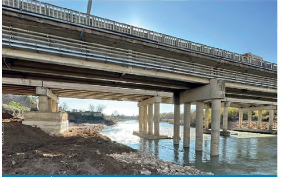
Aksu Köprü Ayagi İyileştirme
