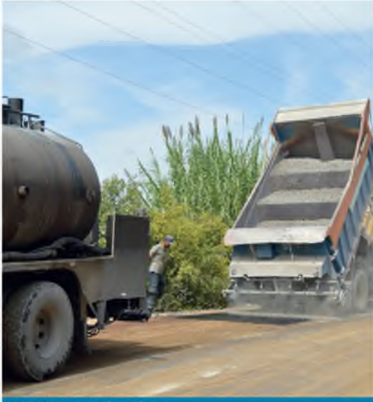
Sathi Kaplama Çalışmaları
